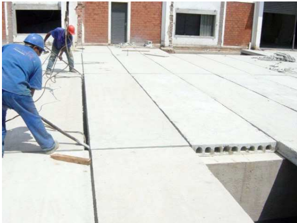
Figura 16 – Placa sendo deslocada até a sua posição
