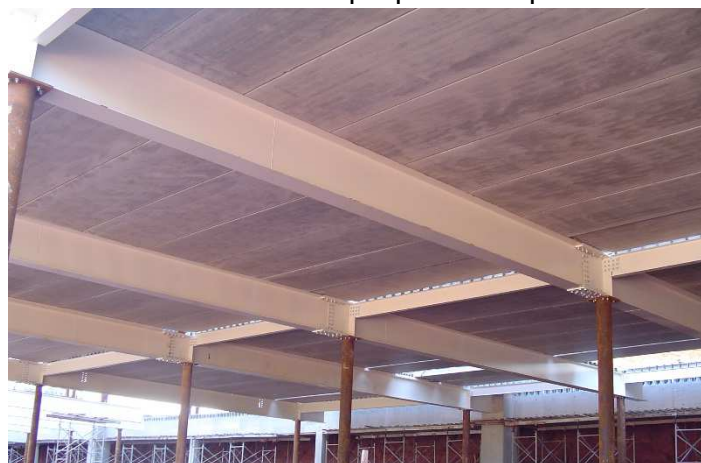
Figura 5 - Acabamento inferior da laje Alveolar
