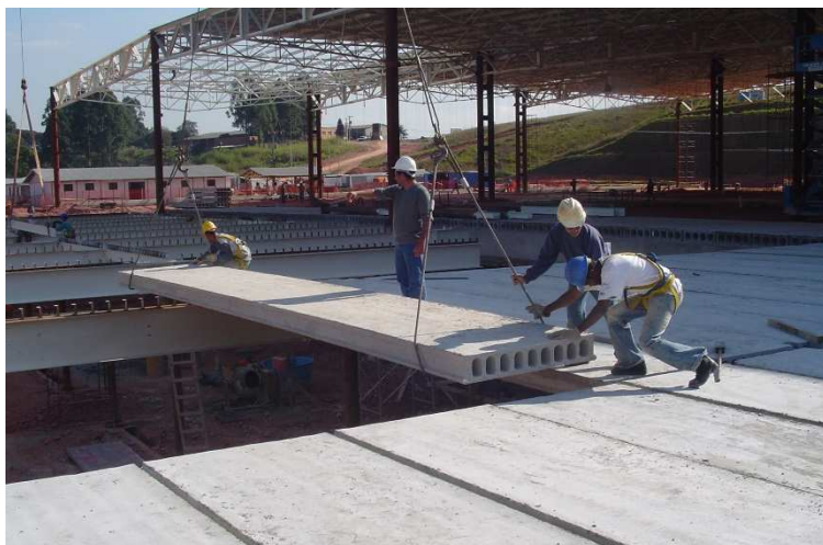
Figura 2 – Montagem das Lajes Alveolares
