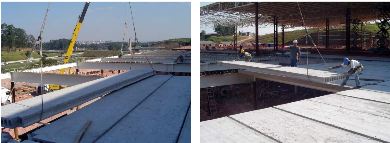
Figura 15 – Placa sendo deslocada até a sua posição de montagem
